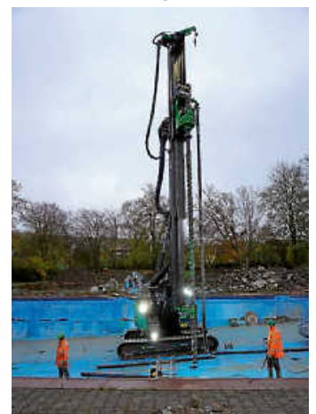
Die Becken im Freibad Michelbach erhalten eine hochwertige Edelstahlaukleidung
