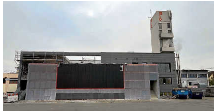
An der Südseite der neuen Fahrzeughalle wurde die vertikale PV-Anlage befestigt Foto: Feuerwehr Öhringen
