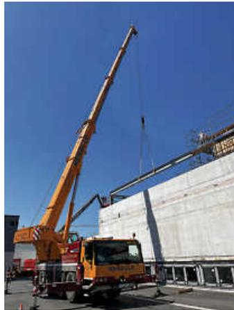
18 Meter lang und 3,5 Tonnen schwer war der Stahlträger als Kernstück der Dachkonstruktion im neuen Feuerwehr-Anbau
