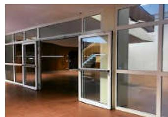
In dem großzügigen und stufenförmig angelegten Gebäude der Schule wurden mit neu eingezogenen Glastrennwänden Brandschutzbereiche angelegt, die im Brandfall ein Übergreifen der Flammen verhindert
