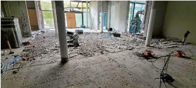
In der Sauna und den dortigen Duschen werden aktuell der Fußboden, die Fliesen und die wasserführenden Leitungen erneuert
