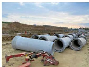
Im Limespark werden rund 600 Meter an Rohrleitungen zur Regenwasserableitung verlegt. Das hilft bei Starkregenereignissen. Sie haben einen guten Meter Durchmesser
