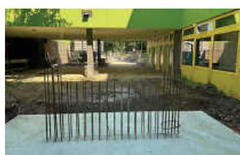
In den Sommerferien werden die neuen Brandschutztreppen außen am Gebäude eingebaut
