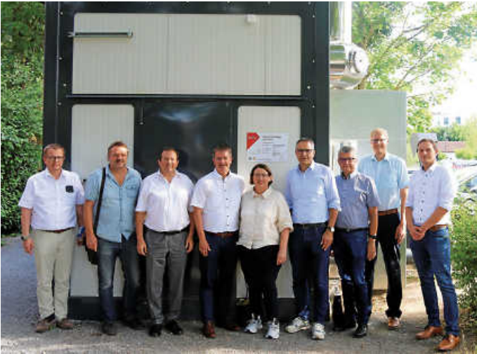
Der Aufsichtsrat der Stadtwerke Öhringen vor der neuen Hackschnitzelanlage am Freibad Foto: Stadtwerke Öhringen
