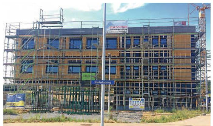
Ein neuer Kindergarten entsteht im Limespark: die AWO Bewegungskita „Purzelbaum“ Foto: Stadt Öhringen
