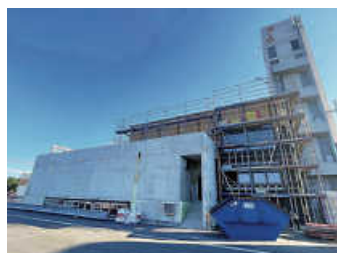
Anbau an der bestehenden Feuerwehrehalle (Blick hofseitig)
