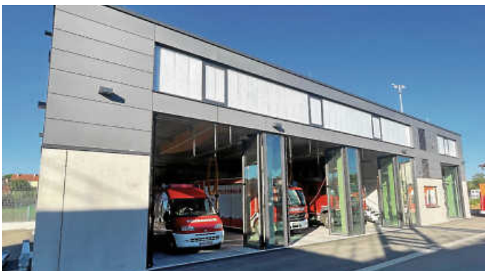
Die neue Fahrzeughalle ist fertig und wird bereits genutzt
