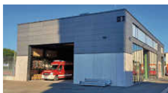
Die Fahrzeughalle bekommt rückseitig noch eine vertikale PV-Anlage an die Wand gesetzt
