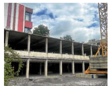
Sanierung C-Bau/Fahrradkeller Fotos: Stadt Öhringen
