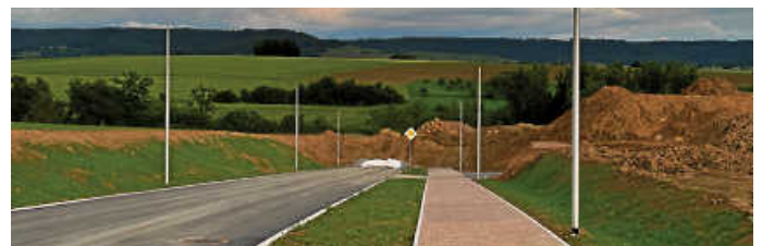
Fertigstellung der Ströllerbachallee Richtung Süden/S-Bahn
