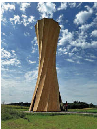
22 Meter hoher Aussichtsturm in Holzbauweise auf dem Schönbühl in Wangen
