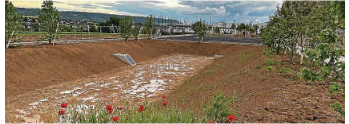
Für das Regenwasser wurde ein Rückhaltebecken gebaut
