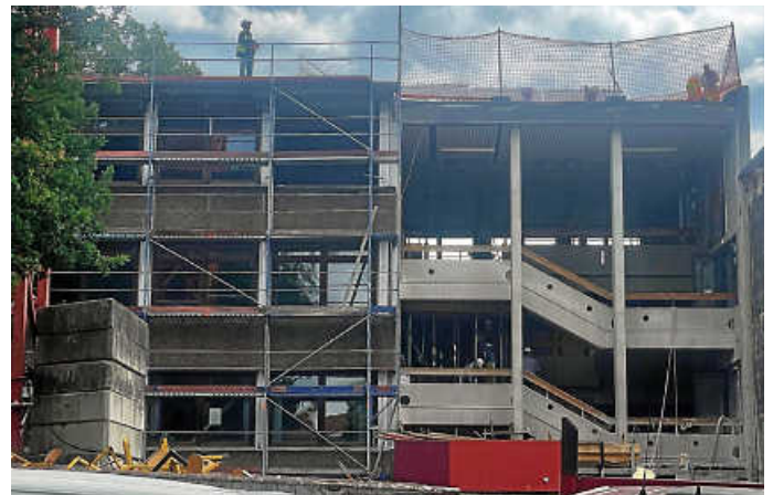
Freigelegtes Treppenhaus des C-Baus
