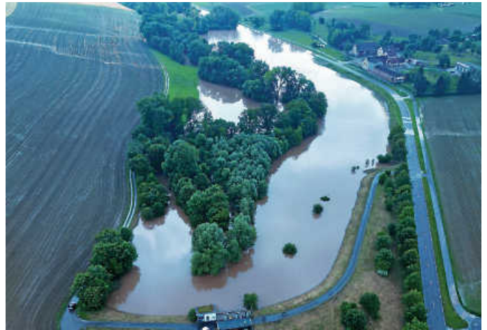
Vollgelaufenes Regenrückhaltebecken Cappel Foto: Michael Peters
