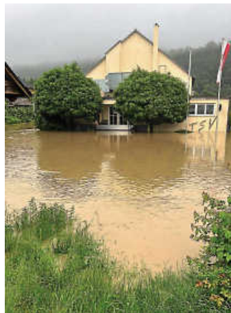
Hochwasser am TSV Ohrnberg – das Wasser konnte aus dem Keller herausgepumpt und so Schäden vermieden werden
