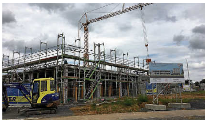
Gebaut werden die neuen Gebäude in Holzbauweise nach den Richtlinien der Deutschen Gesellschaft für Nachhaltiges Bauen
