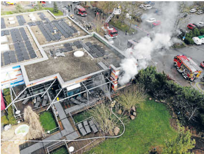
Die Sauna im Rendel-Bad ist ausgebrannt. Auch das Hallenbad ist von den Brandschäden betroffen Foto: FFW Öhringen
