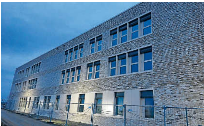
An der neuen Grundschule Limespark mit Doppelstorthalle soll zusätzlich ein Quartiersplatz entstehen. Die Bauarbeiten dazu werden in der Gemeinderatssitzung am 27. Februar vergeben
