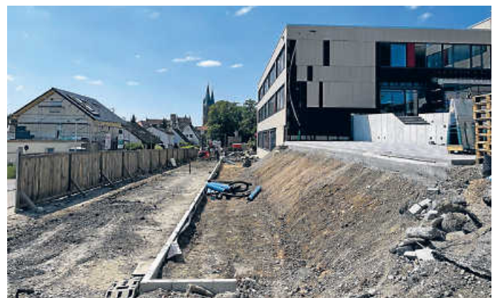
Richten der Außenanlagen
