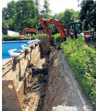
Rohrsanierung im Bädle Michelbach im Jahr 2019
