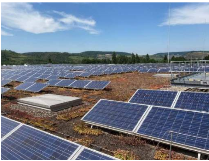
Foto 3: Beispielhafte Darstellung einer extensiven Dachbegrünung in Kombination mit PV-Anlagen ( Fotoaufnahme: ÖKOPLANA)
