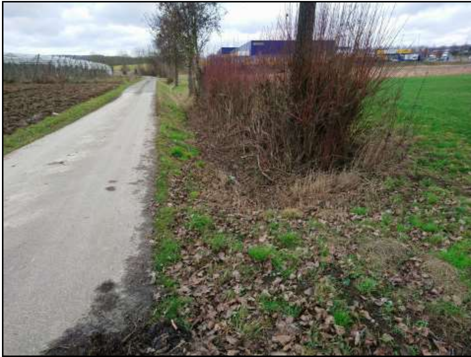
Abb.18: Quellbereich des Hapbachs an L1036. In der Mitte am rechten Bildrand könnte ein neuer Graben angelegt werden und hier enden, um die Wassersituation hier zu verbessern.
