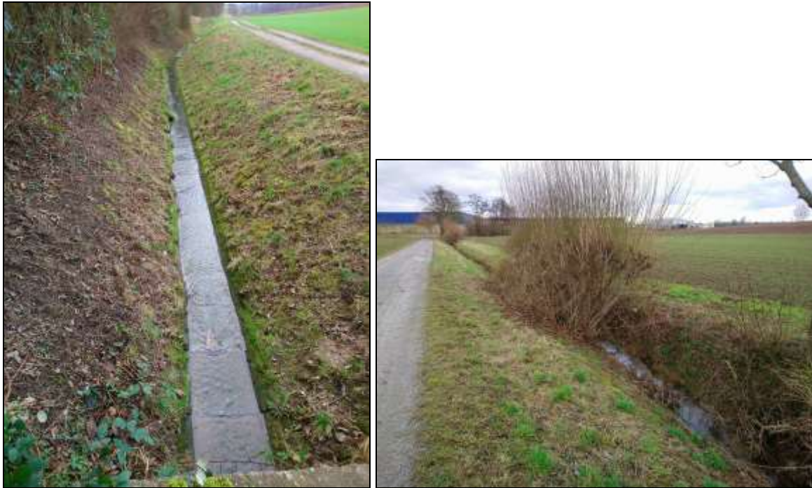
Abb.9: Hapbach (Aufnahmen vom 05.02.2022). links: vollständiger Sohlschalenverbau unterhalb Vorhabengebiet rechts: Trapezausbau, begradigt, parallel Feldweg, kaum Gehölze
