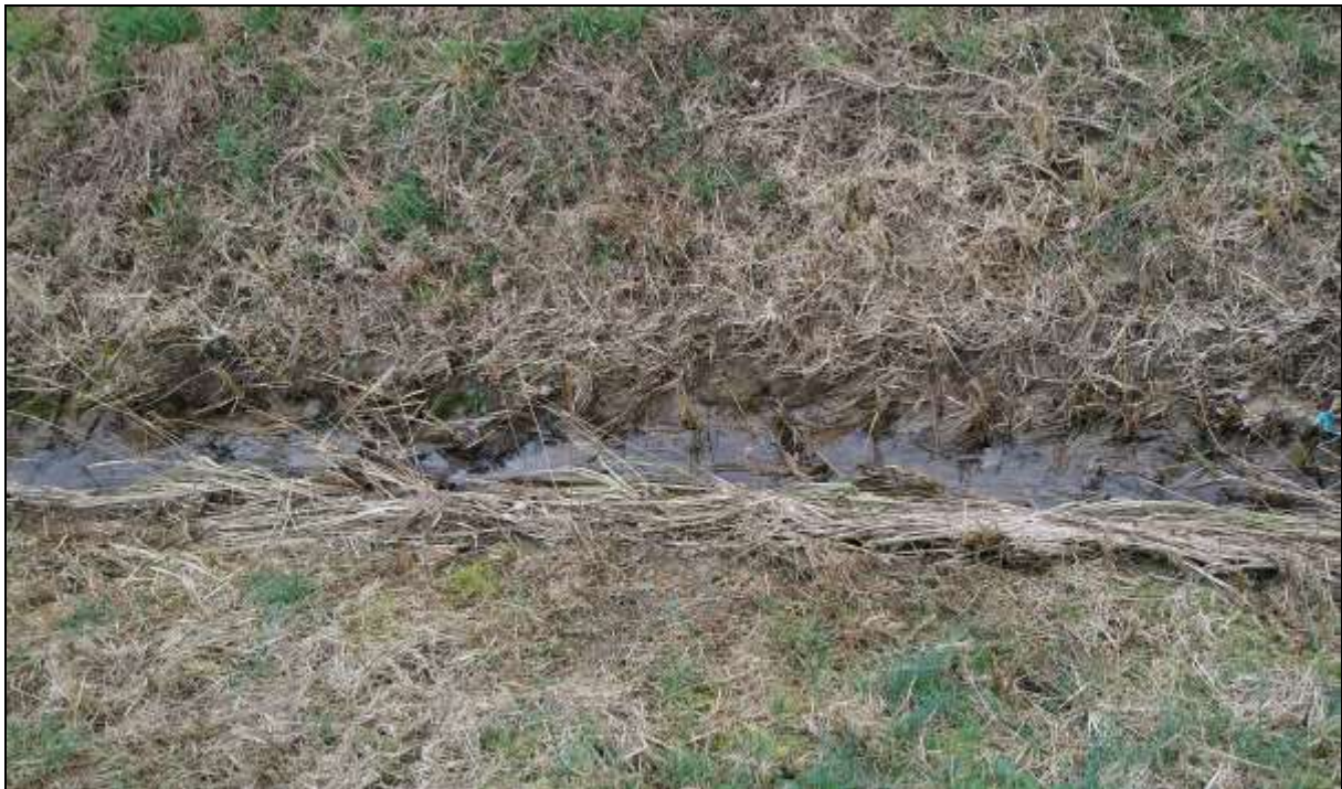
Abb.5: Bereich B2 am Seitengraben auf Höhe RWK vor Einmündung in den Hapbach - Bildeindrücke der Messstelle vom 05.02.2022. oben: Blick in Gegenstromrichtung zur A6 hin unten: frontal mit überwachsener Betonschalensohle
