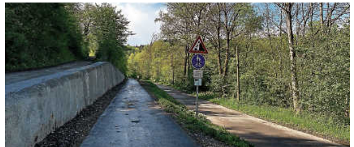
Die sanierte Stützmauer am Kochertalradweg
