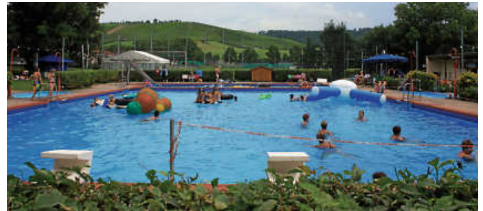
Das „Bädle“ in Michelbach wird vollumfänglich saniert und bekommt neue Edelstahlbecken Foto: Stadt Öhringen
