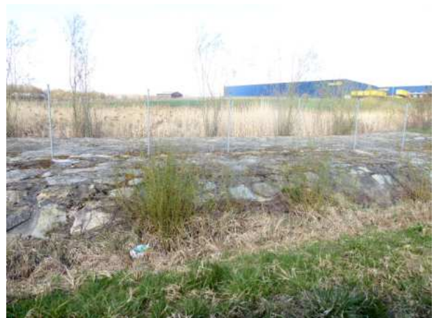
Abb. 15: Retentionsbecken für Oberflächenwässer (auf Flst.-Nr. 841/2) mit Schilfbewuchs und noch kahlem Gehölz.
