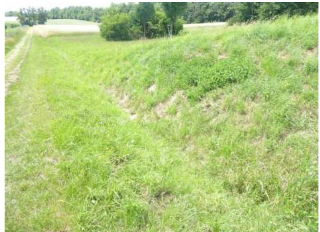
Abb. 25: Östlicher Teil des unbefestigten Feldwegs (Flst.-Nr. 840) mit angrenzender Böschung.
