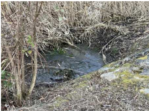
Abb. 41: Temporär wasserhaltender Bereich im Retentionsbecken auf Flst.-Nr. 841/1.
